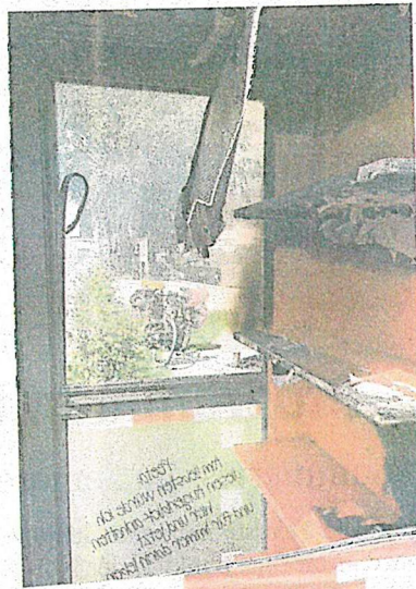
Die größten Spuren hat der Bauhof mittlerweile schon beseitigt, vor allem hat er die verkohlten Bücher entfernt.
